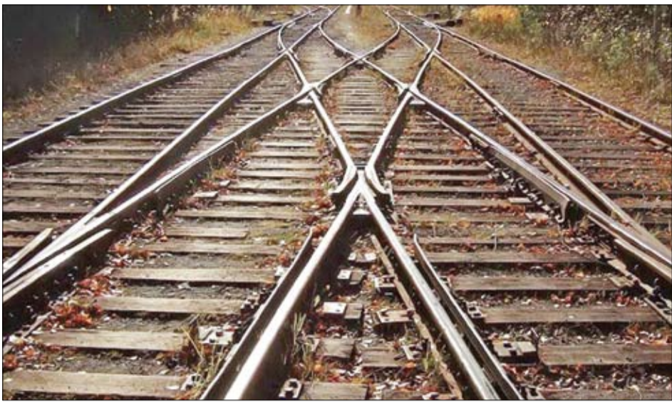
راه آهن گرگان- بجنورد- مشهد در حال احداث است.
